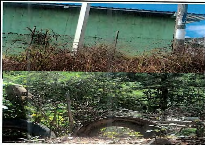
Foto1: Mejoramiento de cerco o muro perimetral
