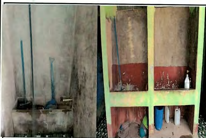
Foto 3: Mejoramiento de Baños
