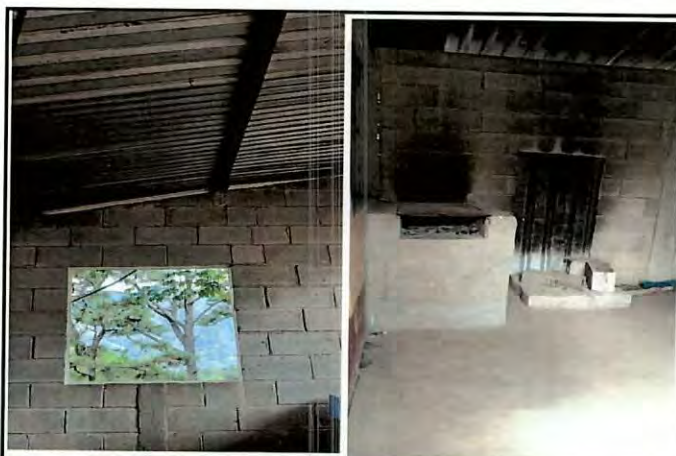
Foto 4: Mejoramiento de Cocina
